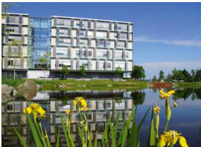
Am Krankenhaus St. Elisabeth ist ab Herbst 2017 der zweite große Bauabschnitt abgeschlossen.
