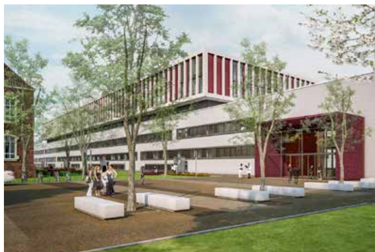
Neubau Betten- und Funktionshaus M
