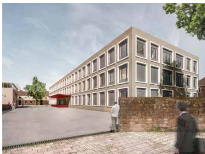
Neubau Institutsgebäude Haus I
